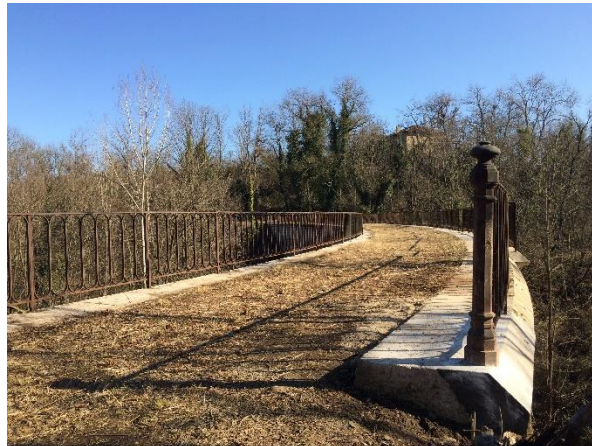
Pont du Tram février 2022
