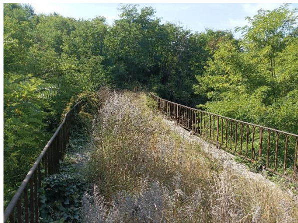
Pont du Tram novembre 2021
